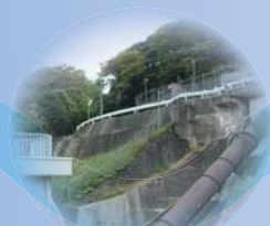
中部電力波多瀬発電所
